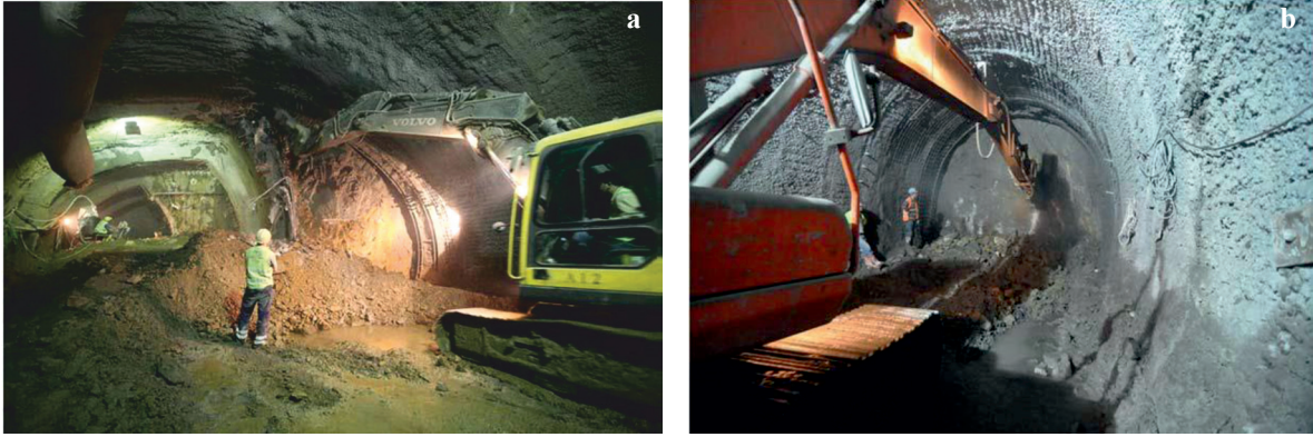
Şekil 5. Üst yarı (a) ve alt yarı kazı (b) olmak üzere iki kademedeki yapılan tünel kazıları.
